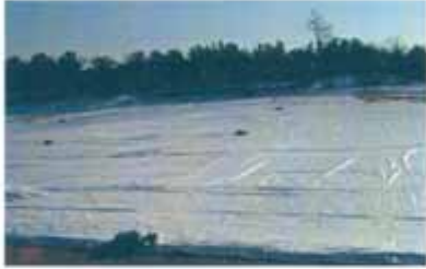
★ 그린커버 설치 사진 ★
